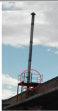
FOTOGRAFIA 9. DUCTO DE HORNO ROTOMOLDEO
